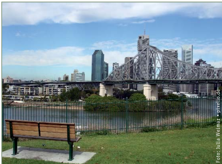
> Customer First Project: Brisbane setzt auf zuverlässigen Service und Fahrgastinformation.
