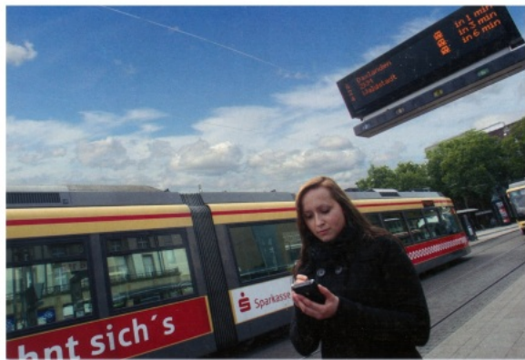
Das in Karlsruhe von INIT installierte dynamische Fahrgastinformationssystem »MOBILE-STOPInfo« liefert zuverlässige Informationen über die tatsächlichen Abfahrtszeiten an allen Haltestellen.
